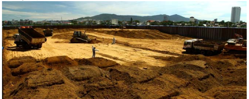
Đưa đất và bùn bị nhiễm bẩn vào kết cấu móng
