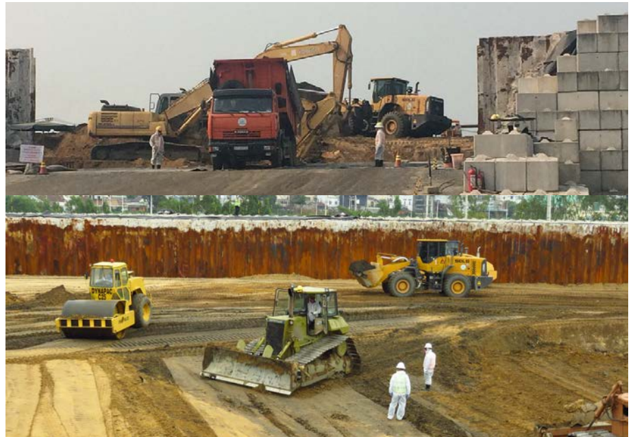
Đổ và đầm chặt đất nhiễm vào trong kết cấu xử lý
