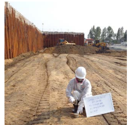
Thử nghiệm độ chặt đất/bùn trong kết cấu xử lý nhiệt.
