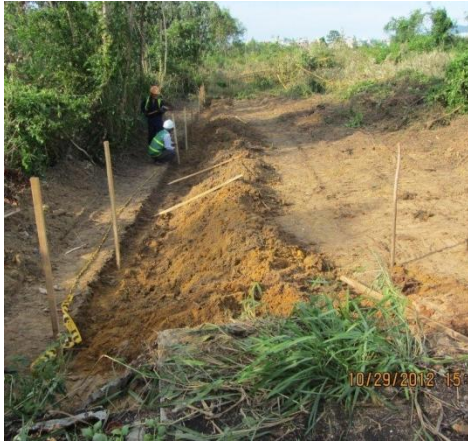
Thi công rào chắn bùn (Ảnh: CDM Smith)
