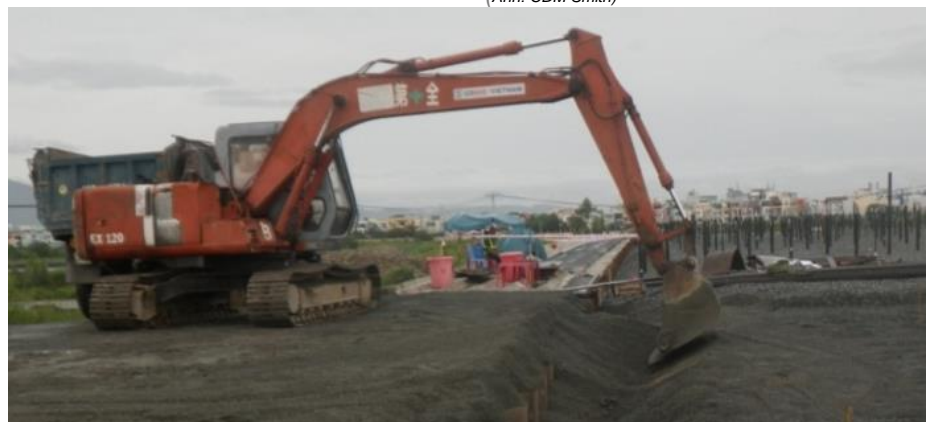
Phủ lớp đá dăm lên bề mặt đỉnh của kết cấu móng (Ảnh: CDM Smith)
