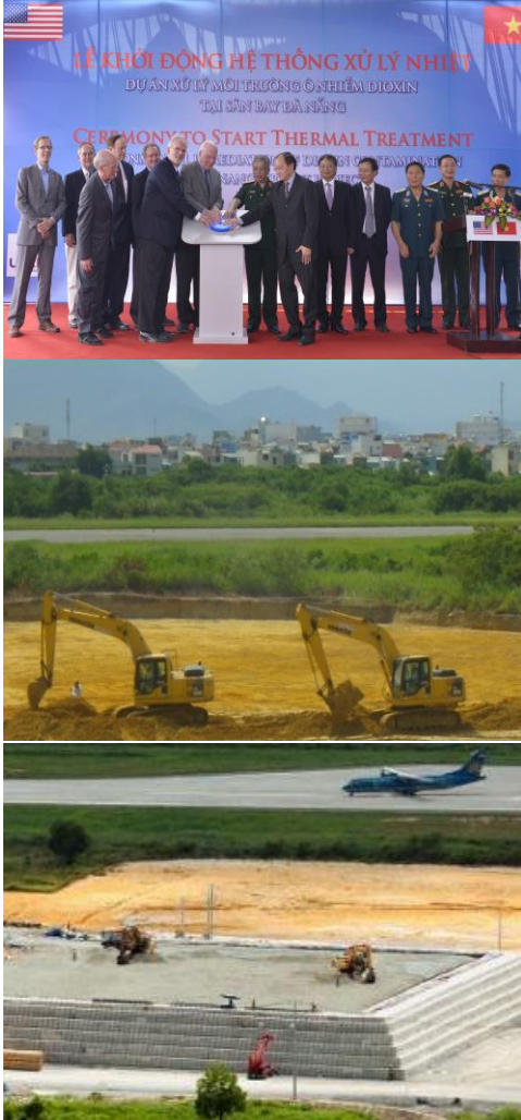
Các nhà thầu của USAID thực hiện đào xúc đất nhiễm bản dioxin và đưa vào kết cấu móng tại Sân bay Đà Nẵng
